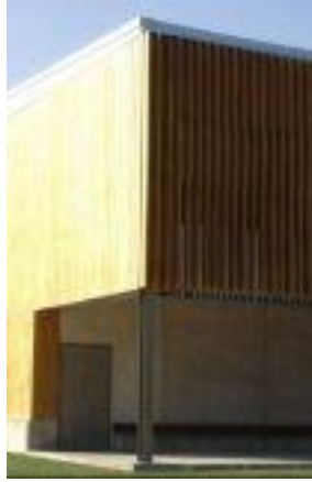
Figura 7 .Material y estructura de Pabellón de Tiro con Arco en el Parque Deportivo de Puerta de Hierro, Madrid
