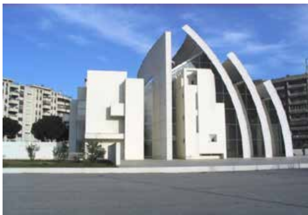
Figura 2. Iglesia 2000, en el año 2003. Fuente http:// www. Plataformaarquitectura.cl/cl /800156/iglesia-del- 2000- richard-meier-and-partners (2003)
