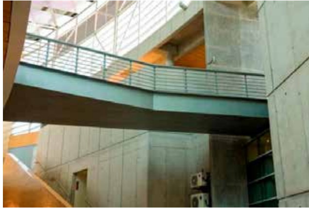
Figura 40. Hormigón a la vista en interiores. Fuente: http://www.plataformaarquitectura.cl/ (2017)
