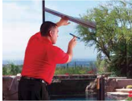
Figura 49. Revestimiento de ventanas. Fuente: www.eastman.com (2017)
