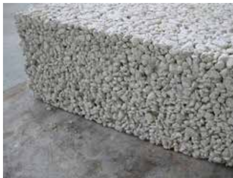
Figura 44. Acabados de Estacionamientos. Fuente: www.hotfrog.com.mx . (2017)
