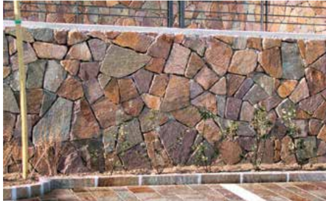
Figura 45. Muros de contención. Fuente: www.archiexpo.es . (2017)
