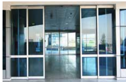
Figura 50. Puerta corrediza automática. Fuente: www.glasstech.cl (2017)
