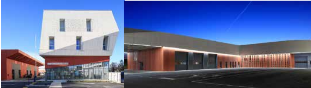
Figura 1 y 2. Centro Técnico de Blagnac, Francia. Fachadas. Fuente: http://www.arquitecturaenacero.org/proyectos/edificios-comerciales-edificios-para-la-industria/centro-tecnico-de-blagnac (2018)
