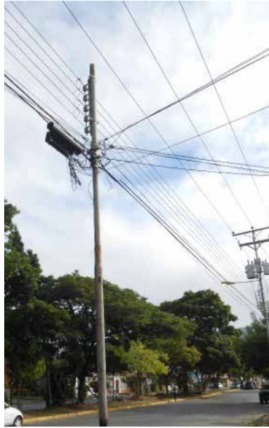
Figura 21. Vista de Muestra Poste calle exterior2 (Av. E-2) Fuente: Bueno, Polanco (2020)
