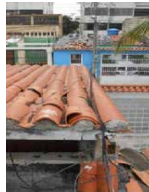
Figura 25. Acometida al usuario descuidada
