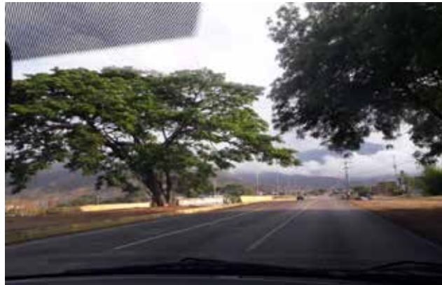
Figura 68. Foto de la canal por donde circula el cauce que viene del río Cúpira y atraviesa la vía, El Tulipán, Municipio San Diego.
