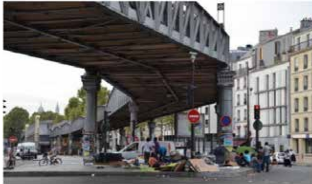
Figura 94. Parte baja Estación Stalingrad, Metro elevado París.
