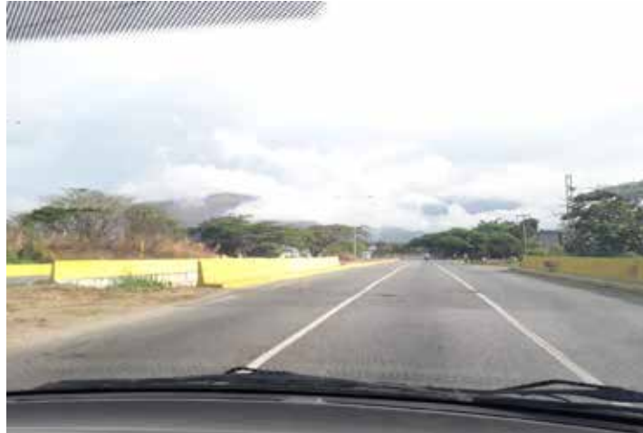
Figura 69. Foto de la canal por donde circula el cauce que viene del río Cúpira y atraviesa la vía, cerca de Frenos Popeye e Hiperlider, Municipio San Diego.
