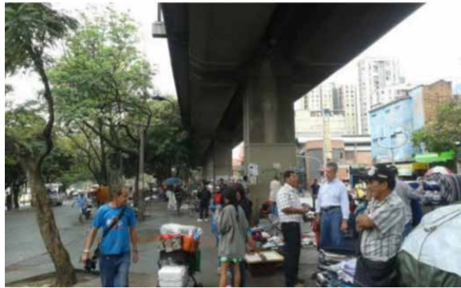
Figura 97. Parte baja estación Prado, Metro elevado Medellín.
