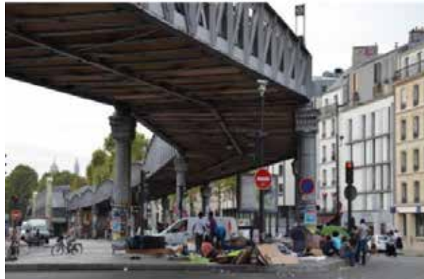
Figura 22. Parte baja Estación Stalingrad, Metro elevado París.
