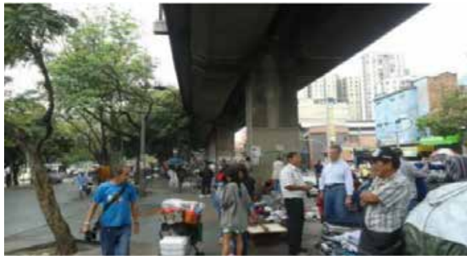
Figura 21. Parte baja estación Prado, Metro elevado Medellín.
