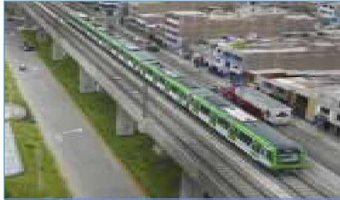
Figura 4. Tramo Línea 1 Metro Lima
