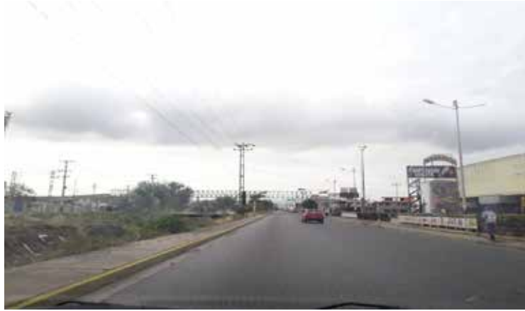
Figura 44. Foto del sector por donde pasaría el Monorriel Elevado, canal y pasarela de estructura de acero en Mega Mercado, entrada a parque valencia, paseo las industrias, Municipio Valencia, Fuente: Foto tomada por los autores, Seco-Torres (2019)
