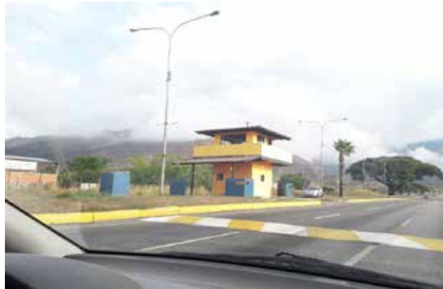
Figura 58. Foto de la tercera Infraestructura de vigilancia vial, El Tulipán, Municipio San Diego.
