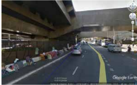
Figura 96. Tramo elevado Línea Azul metro São Paulo
