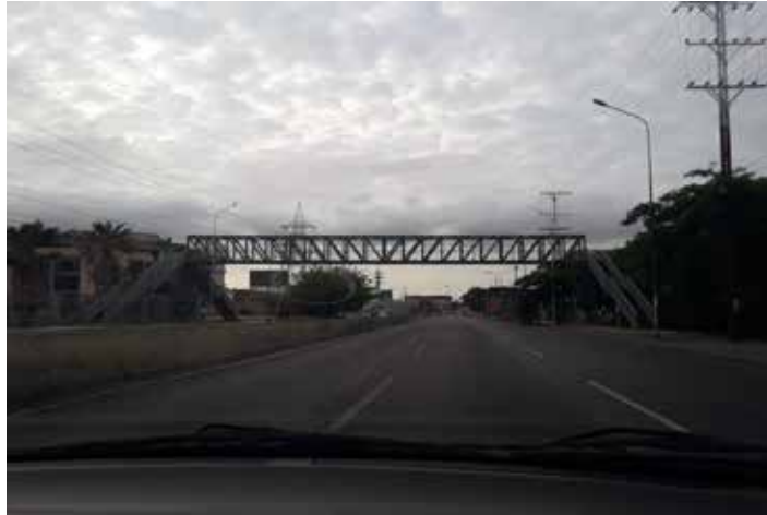
Figura 48. Foto del sector por donde pasaría el Monorriel Elevado, pasarela de estructura de acero, La Isabelica, Municipio Valencia, Fuente: Foto tomada por los autores, Seco-Torres (2019)
