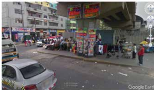
Figura 95. Tramo elevado Línea 1 metro Lima
