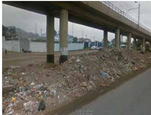
Figura 6. Deterioro entorno estación Pumacahua, Línea 1 Metro Lima Fuente: Google Earth
