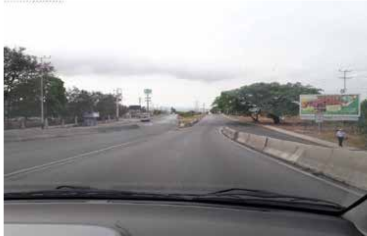
Figura 46. Foto del sector por donde pasaría el Monorriel Elevado, bifurcación de la vía, paseo las industrias, Municipio Valencia, Fuente: Foto tomada por los autores, Seco-Torres (2019)
