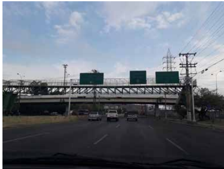
Figura 49. Foto del sector por donde pasaría el Monorriel Elevado, pasarela de estructura de acero e intersección de la avenida Michelena con la Quizanda, Municipio Valencia, Fuente: Foto tomada por los autores, Seco-Torres (2019)
