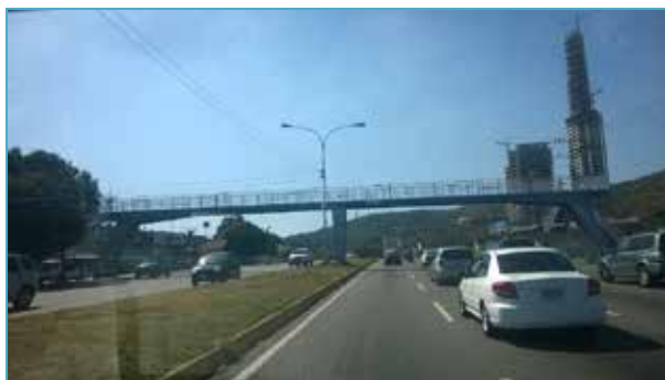
Figura 53. Foto de pasarela, en los Magallanes, Municipio San Diego.
